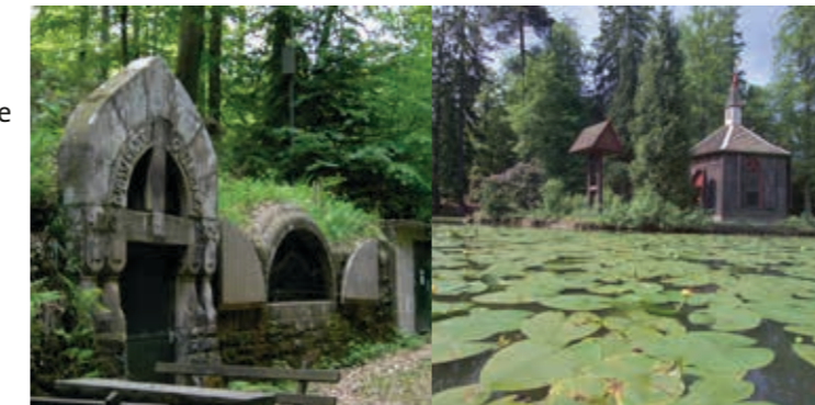
Wasserwerk in Vielbrunn
